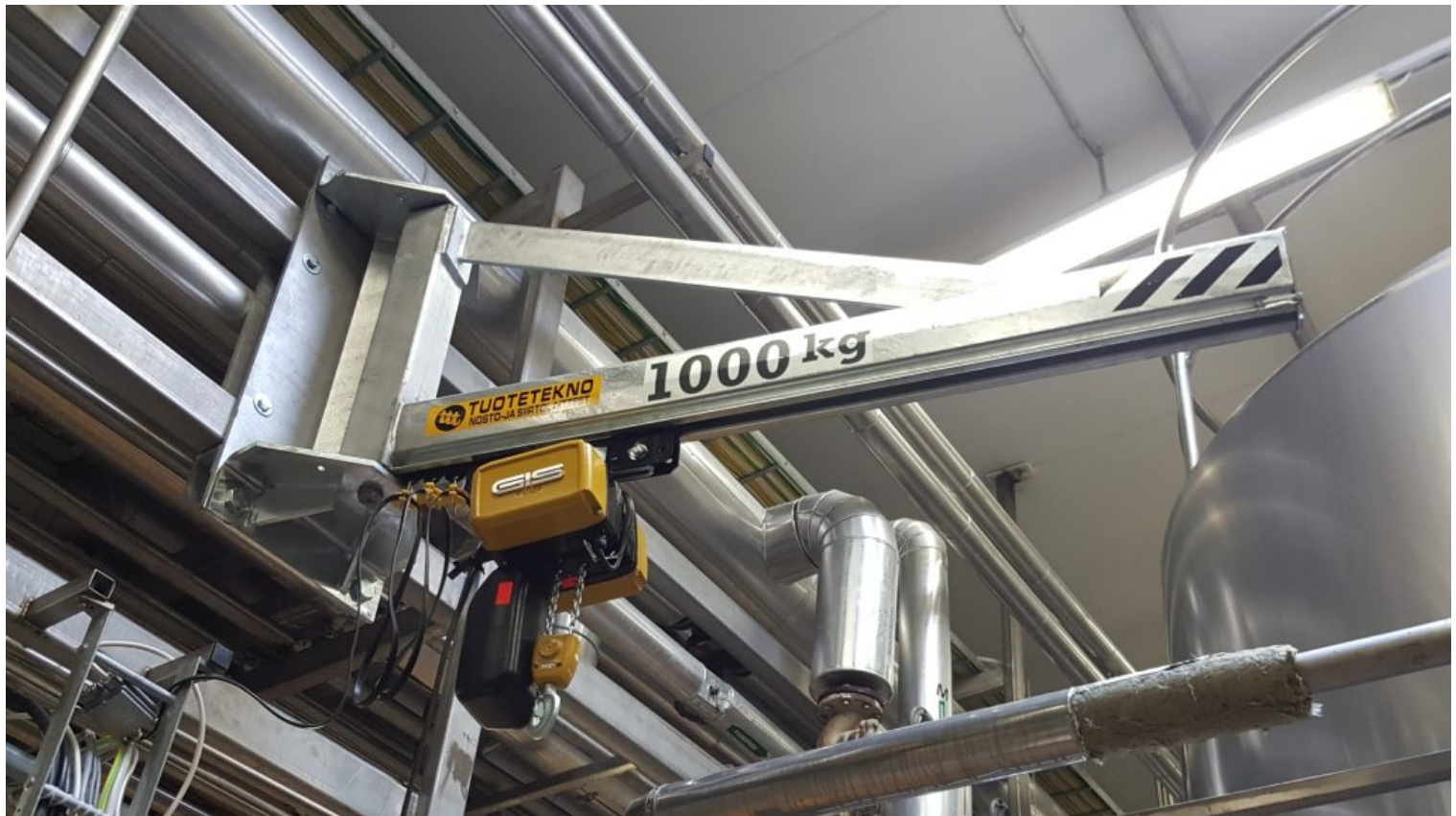
Sinkitty seinäkääntönosturi profiilista
